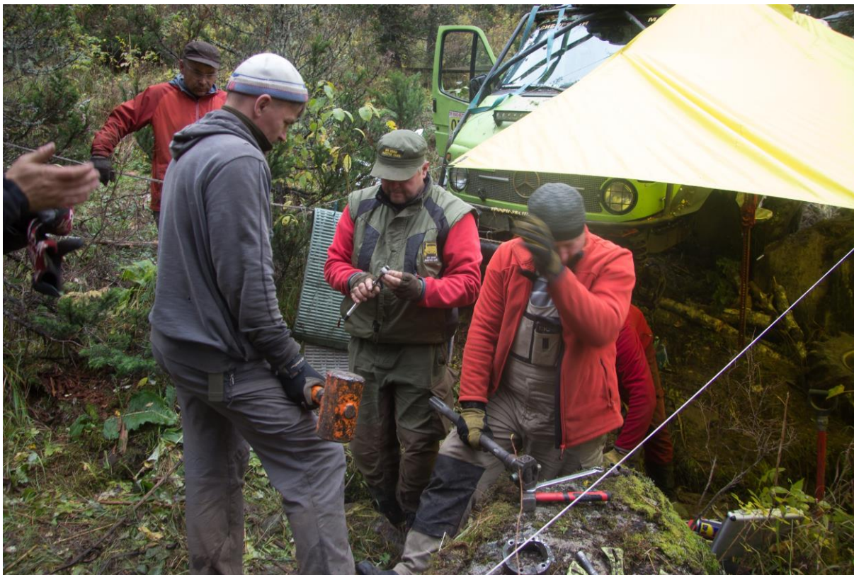
Фото 36. Ремонт на склоне.
